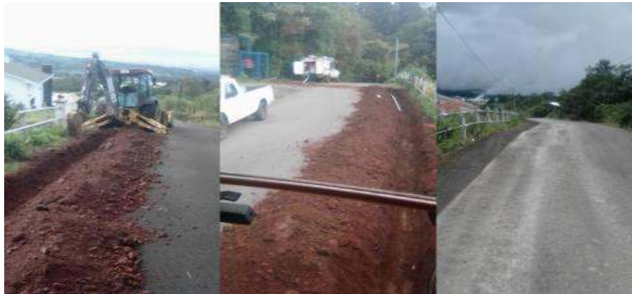
Esto es en el Tirol ahí fueron 100 metros en tubería.
