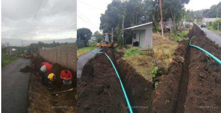
Esto es en las parcelas en calle El Tigre en la parte de arriba, aquí fueron 150 metros de tubería.
