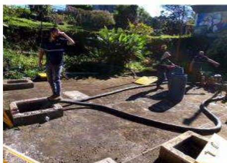
Extracción de 60m 3 de lodo y retrolavado del Fafa
