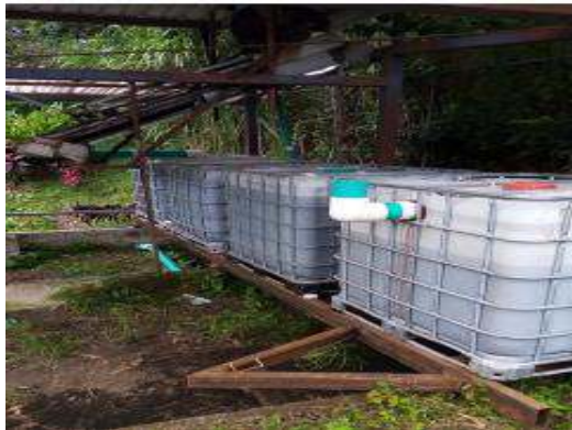
Colocación de 4 tanques sedimentadores
