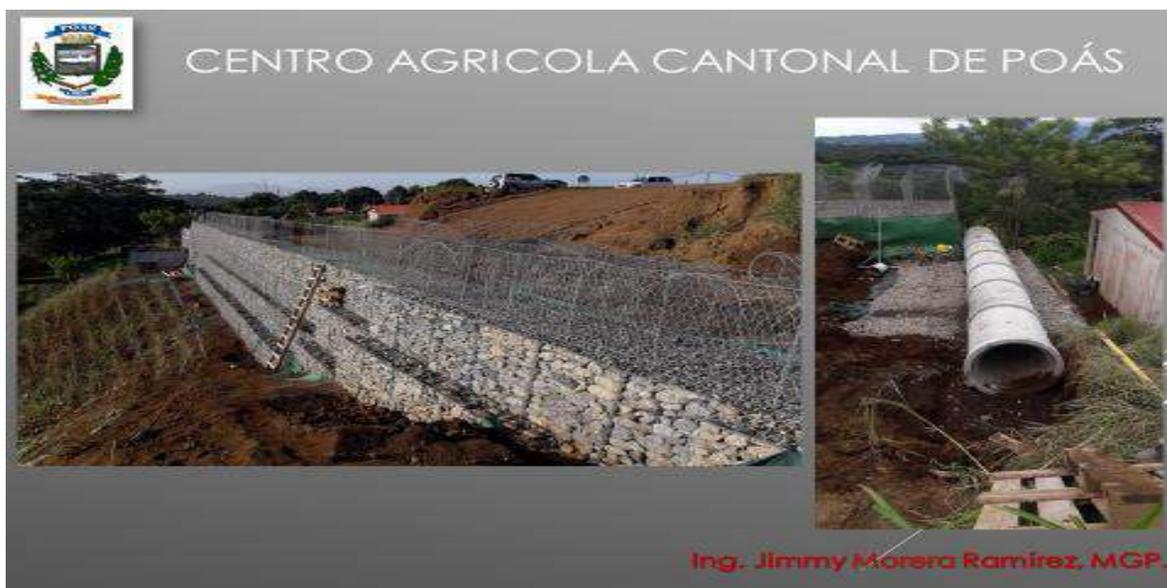
Esta fotografía es de hoy, estamos trabajando en el cierre de la caja pluvial, la boca del tubo que desfoga como se muestra, entonces necesitamos por lo menos subirlo 60cm más arriba de la boca del tubo.
