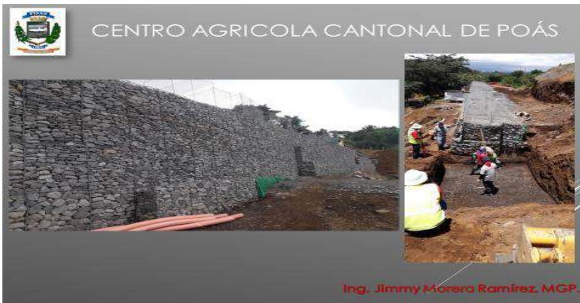
Esto fue como una semana antes de llegar a la corona, lo que vemos es la solución pluvial propuesta por el constructor que en este caso es INCOPOAS, consta de tuberías de concreto que desfogan en una caja pluvial que tenemos en la esquina del muro y lo que hace es que recoge todas las aguas de los parqueos futuros para desfogarlos hacia esa tubería.
