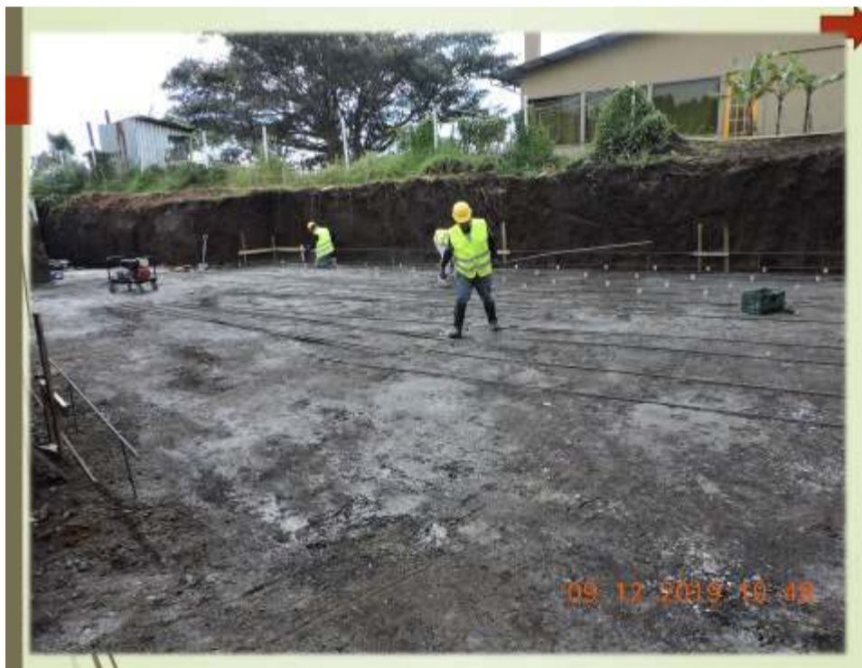
Se inició con la colocación de varilla.
