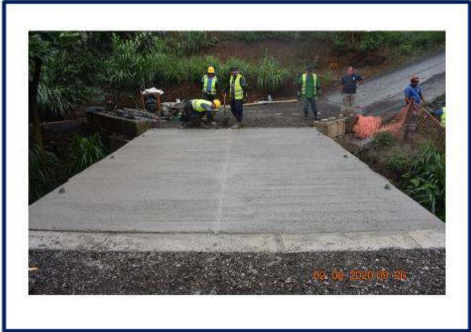
Esta es otra foto del mismo día en la mañana, al ser las 09:00 a.m. estábamos en ese momento colocando el concreto, a través de una bomba telescópica por una chompipa, que ni siquiera pudo llegar al punto, tuvo que estacionarse más arriba, bajar el concreto por un sistema de bombeo.
